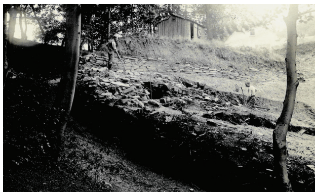
Abbildung 41 Eine mächtige Steinschüttung während der Grabung in den 1920er Jahren könnte auf Reste des verfallenen Haupttores hindeuten. Foto: Fotoarchiv Ruhr Museum
